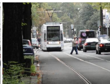
Gleisverlauf teilweise unmittelbar am Bord
