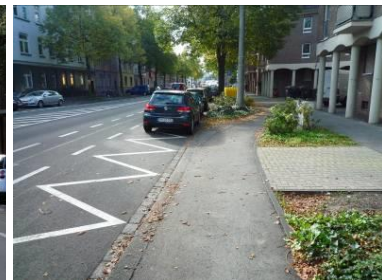
Nordwestseite Hochstadenring – Schutzstreifen, daneben auf den Nebenanlagen ehemaligem Radweg
