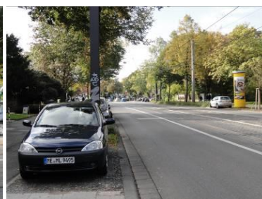
Optische Verbreiterung des Straßenraums durch fehlende Abtrennung der Gleistrasse und gleiche Farbgebung
