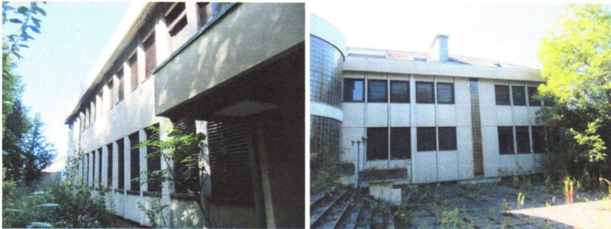
Abb.: Nebeneingang an linker Seite Abb.: Eingangsbereich und Innenhofseite
