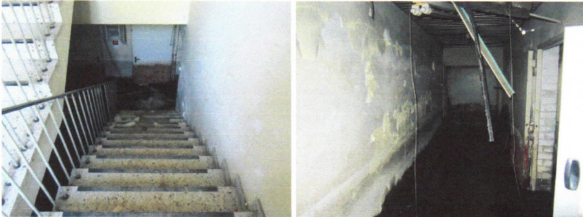
Abb.: Treppenabgang zum Keller Abb.: Flur nach rechts mit Raumzugang
